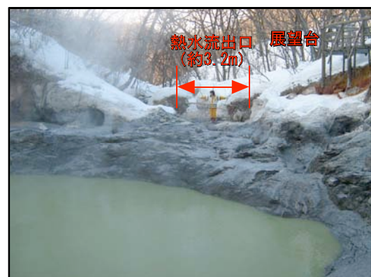
写真2. 拡大した流出口。右上は支柱が露出した展望台(2010年1月21日)
